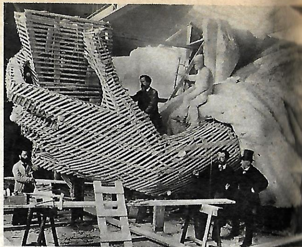
Sopra: in basso a destra Bartholdi, senza cappello, sorveglia la costruzione dell'intelaiatura della mano e del braccio della statua nel laboratorio della ditta Gaget & Gauthier a Parigi. A destra: lo stand con il braccio e la torcia di Lady Liberty, ultimati in tempo per il centesimo anniversario dell'indipendenza americana, fu uno dei punti di maggior richiamo all'Esposizione organizzata a Filadelfia nel 1876 per festeggiare il centenario dell'indipendenza americana.
