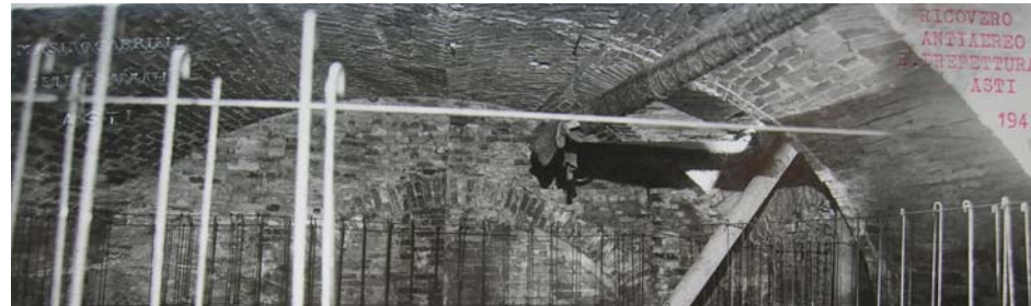
Asti, Il rifugio antiaereo in Palazzo Ottolenghi - 1943. Vista delle armature per solaio in cemento armato.
